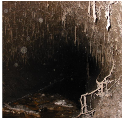
Zustand vor Sanierung
