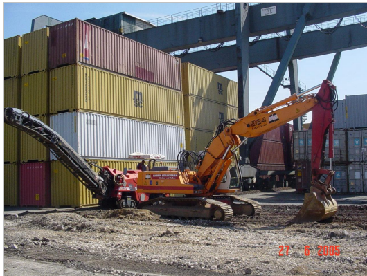
Erneuerung Oberflächen unter laufendem Hafenbetrieb
