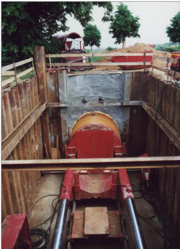
Vortrieb DN 2000 Spannbeton
